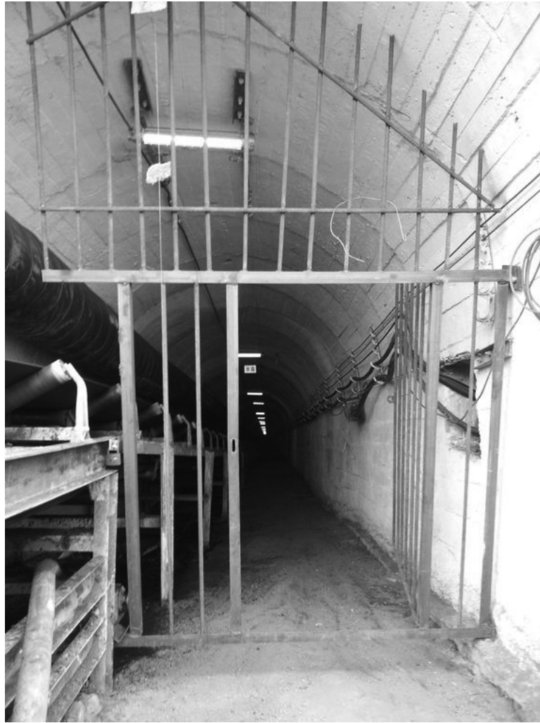
位於金鑫礦區之煤炭運輸機斜井，望向斜井內。
