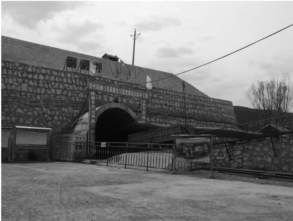
位於鉑龍礦區之煤炭運輸機斜井之入口
